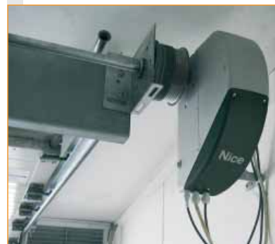
Pohon Sumo může být připevněn přímo na hřídel sekčních vrat
